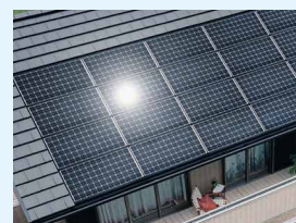
太陽光発電システム
